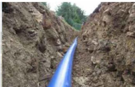
Slika 16. Instalacija HDPE_RC cevi u rov bez posteljice
