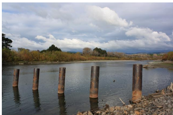
Slika 1. Tipičan usamljeni protočni naper od cevastih šipova [10].
